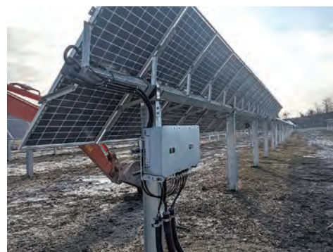
一軸追尾型（両面発電）太陽光発電システム／北海道千歳新川ソーラーパーク
