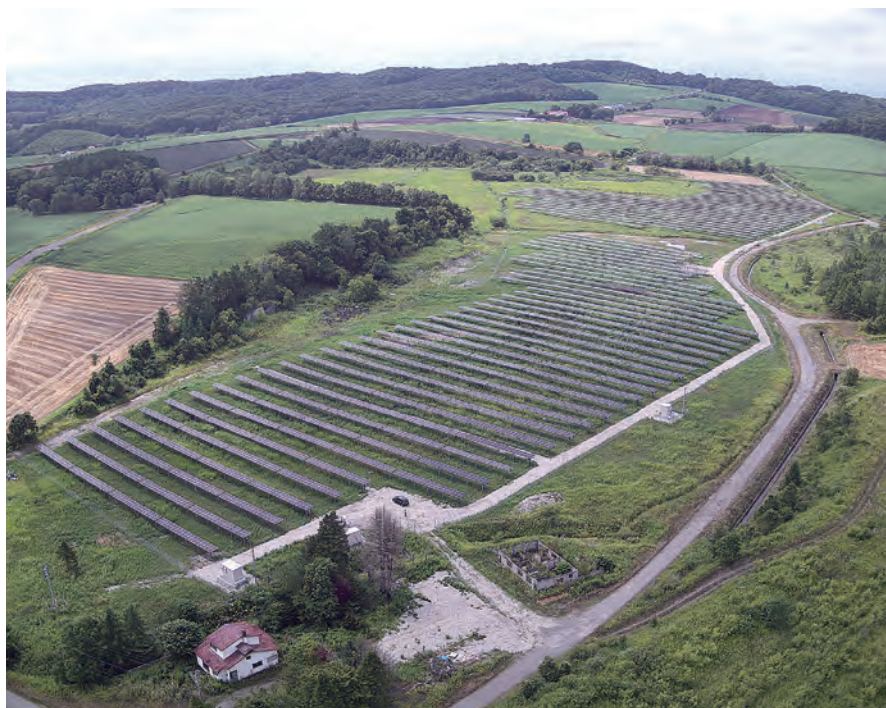
一軸追尾型（両面発電）太陽光発電システム／北海道千歳新川ソーラーパーク
