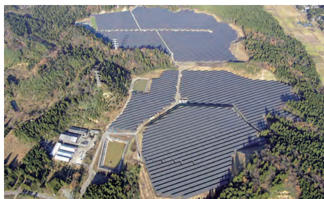
戦略的融資の第1号案件となった「阿賀野市山寺太陽光発電所」
